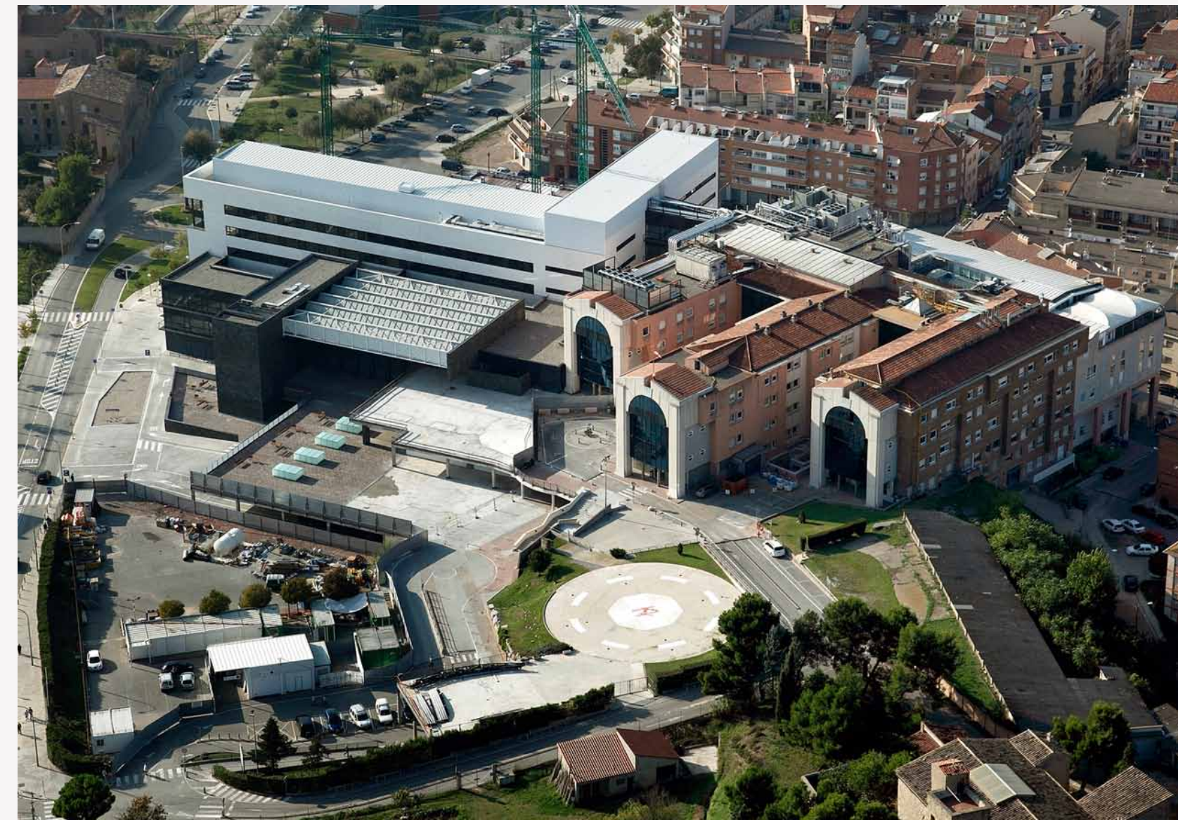
Hospital Sant Joan de Déu de Manresa
